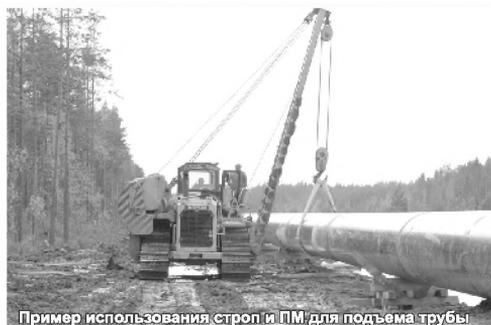
Пример использования стропа и ПМ для подъема трубы
